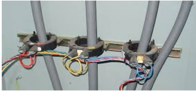
Рисунок 1.3 – Загальний вигляд трансформатора для вимірювання струму
